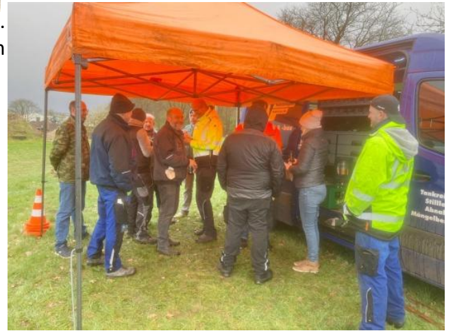
Oben: Es ist geschafft, Der Bauzaun steht und unsere Helfer können entspannen.
